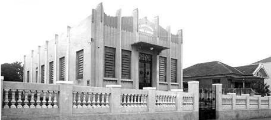
1934 - Sede própria (primeiro piso da atual sede).
