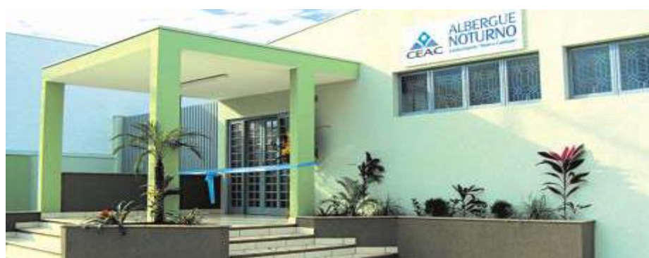
Novo prédio do Albergue inaugurado em 1º de julho de 2011
