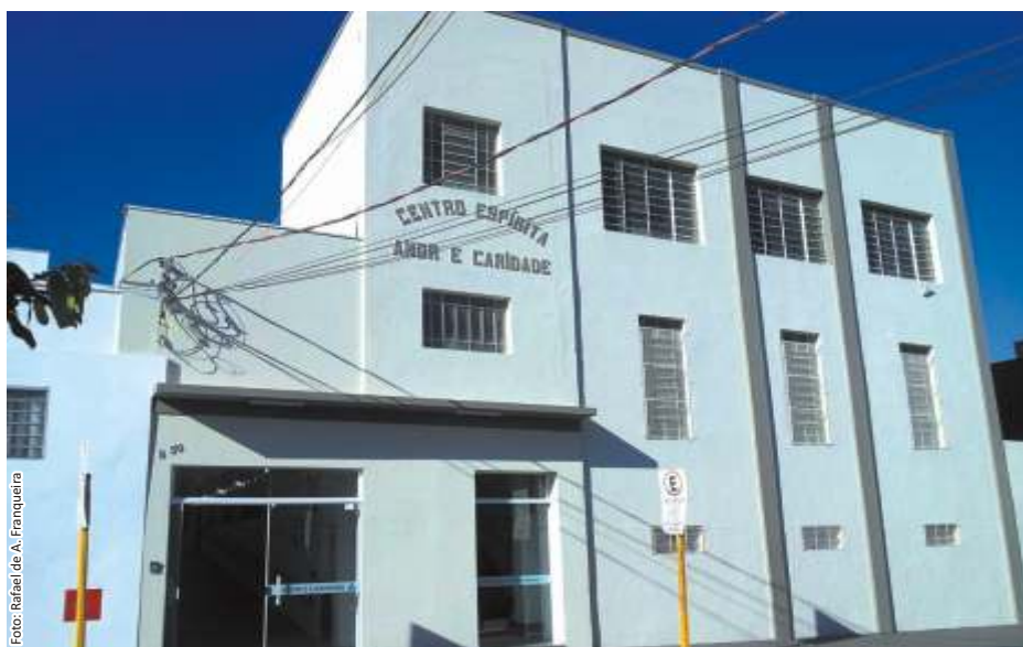
2015 - Sede atual com entrada remodelada
