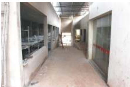
Entrada vista do fundo com rampa concretada
