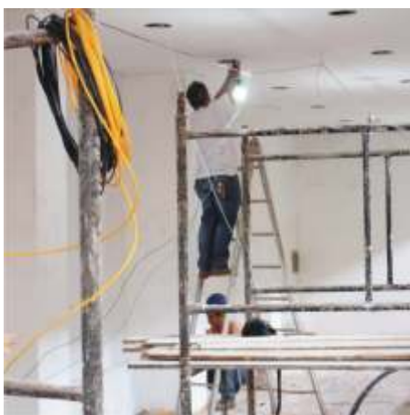
Livraria recebendo instalações de luminárias
