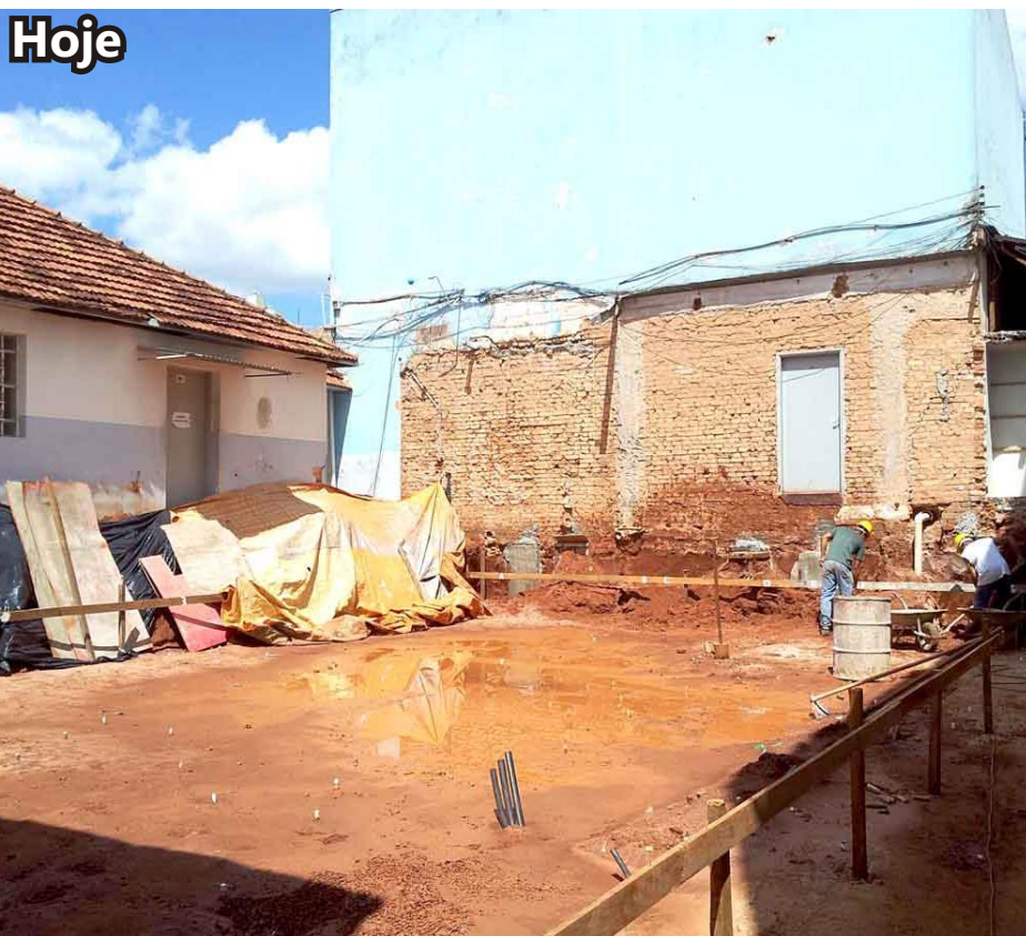
23/03/2015 - Fundos do CEAC, onde será construído um prédio de três andares
