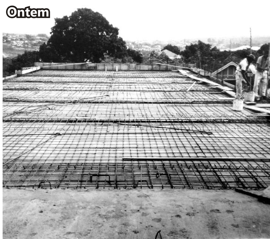
10/10/1949 - Armação da laje do teto do dormitório principal
