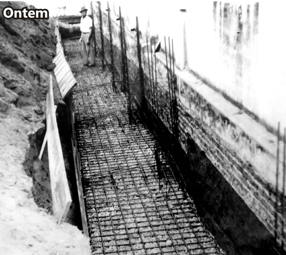
01/12/1948 - Armação do "Radier" junto ao salão principal do Centro, lado esquerdo destinado aos pavimentos superiores
