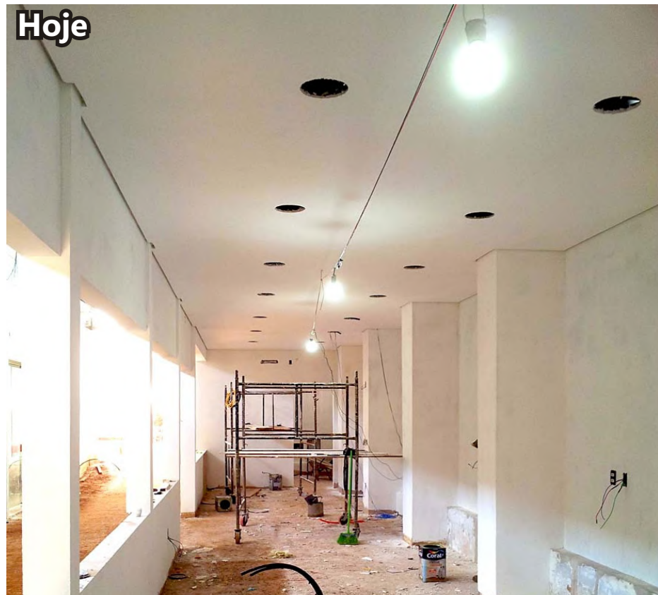
23/03/2015 - Na entrada do CEAC, em acabamento, a futura e moderna Livraria Espírita
