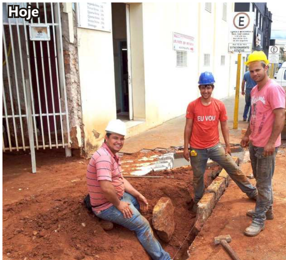
Trabalhadores na construção da calçada, com acessibilidade aos portadores de deficiência física
