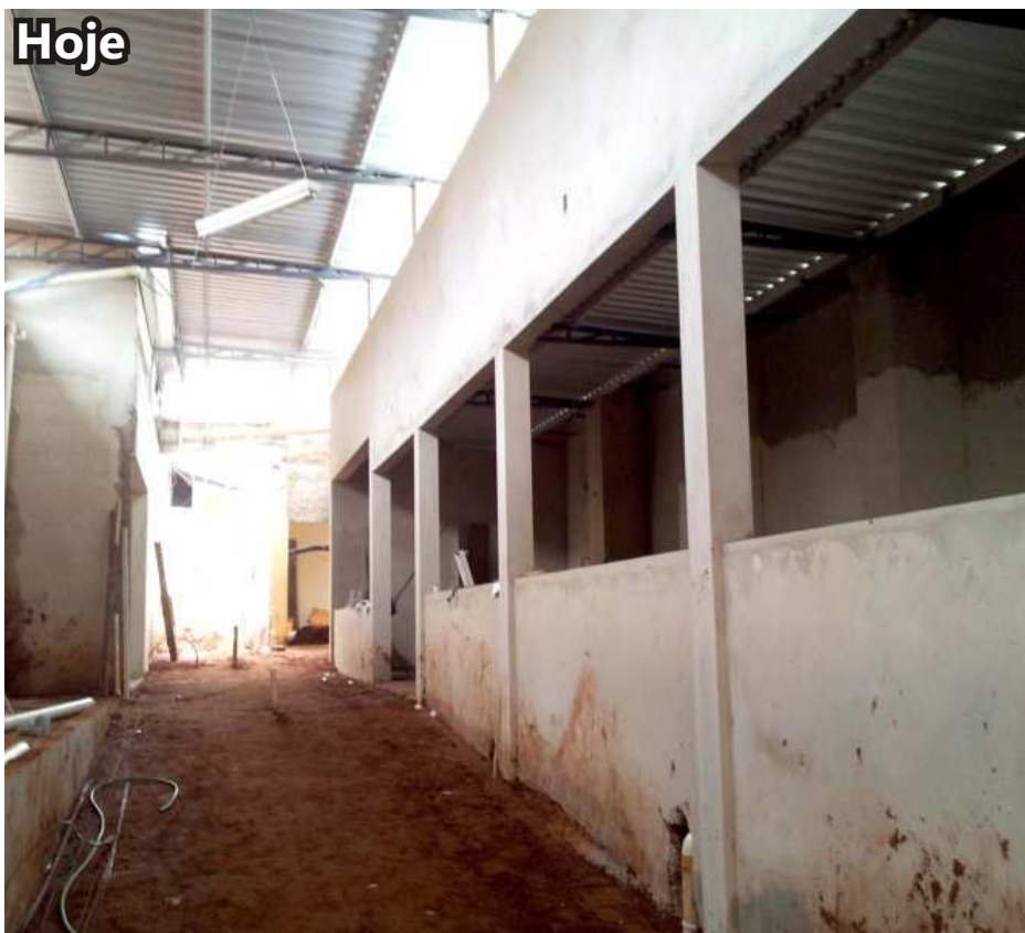
Entrada principal do CEAC em construção, com destaque para a rampa de acesso e futura Livraria ao lado direito
