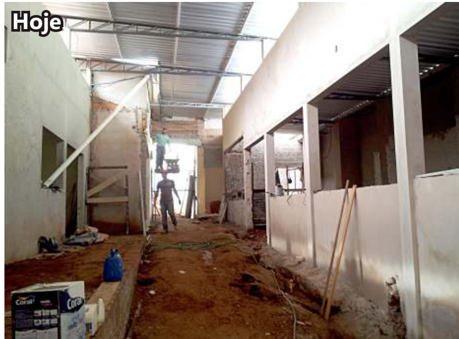
2015 - Reforma da entrada principal do CEAC, com rampa de acessibilidade em construção, e ao fundo haverá um elevador para nove pessoas.
