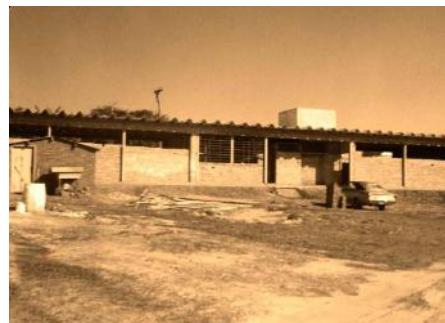
Construção da Creche Berçário Nova Esperança em junho de 1980
